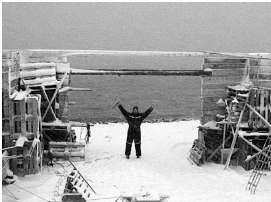
Jørgen viser diensjonene på porten etter at røstmora er lagt på - en drøyt 10 meter lang granstokk hentet fra granskogen på Indregard
