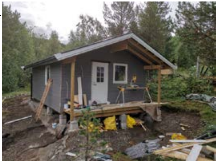
Nybygg: Råbygget er kommet under tak
