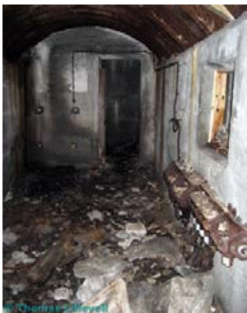
Til venstre: Sambandsrom i kommandobunker
