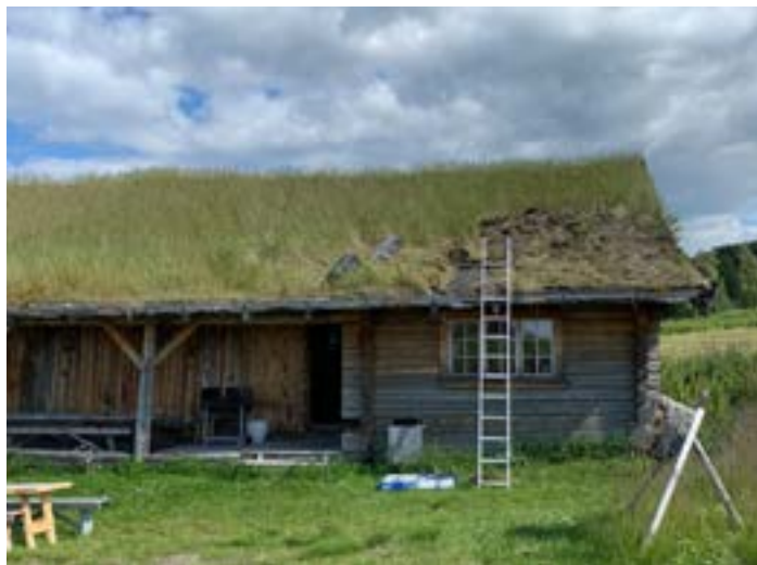
Ta tak: Det er hardt arbeid å legge ny underlagspapp
