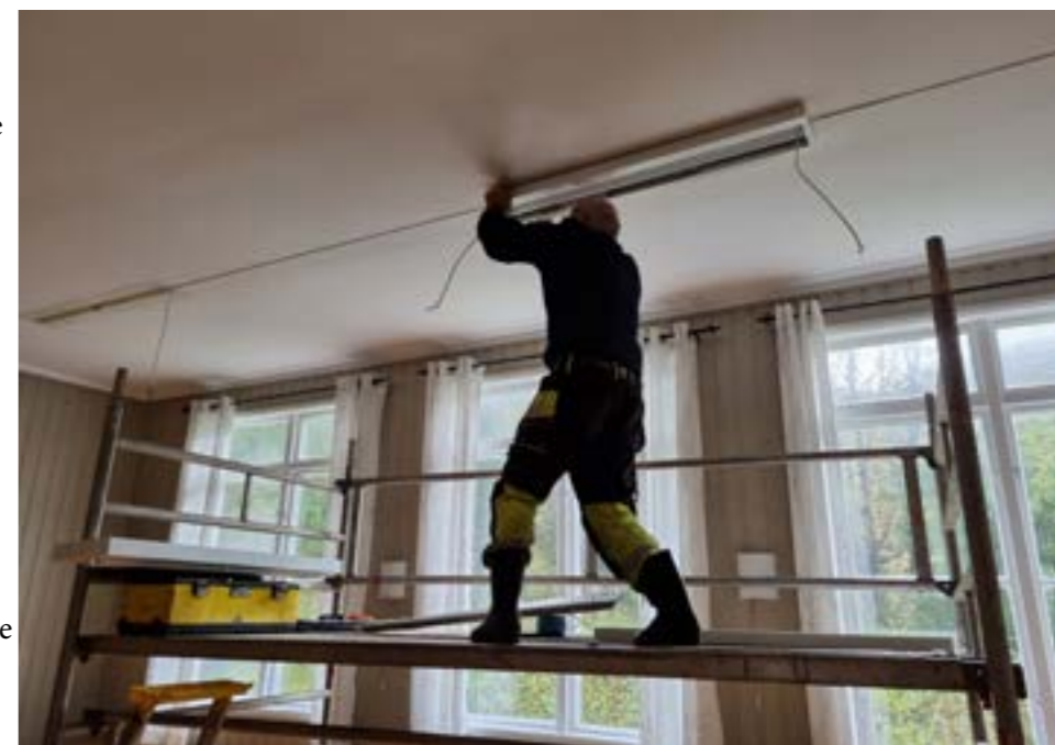
Nye armaturer settes opp i klasserommet
