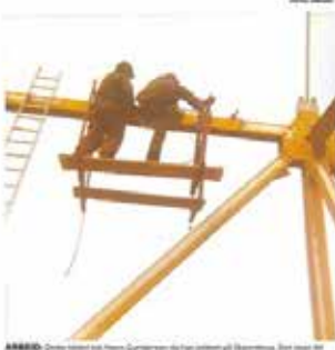
ARBEID: Østfoldregionen er på vei mot Skjombrua. Her er det allerede bygd opp mye av konstruksjonen. Det er nå på vei opp på plass. (Foto: Østfoldregionen)
