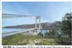
10.11.2022: Østfoldregionen er på vei mot Skjombrua. Her er det allerede bygd opp mye av konstruksjonen. Det er nå på vei opp på plass. (Foto: Østfoldregionen)
