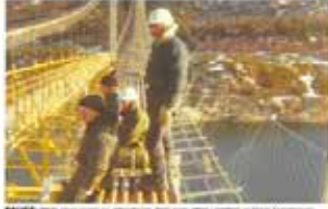
PHOTO: Østfoldregionen er på vei mot Skjombrua. Her er det allerede bygd opp mye av konstruksjonen. Det er nå på vei opp på plass. (Foto: Østfoldregionen)
