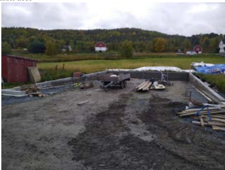
Status før snøen kom og la seg. Krona er støpt og klar
