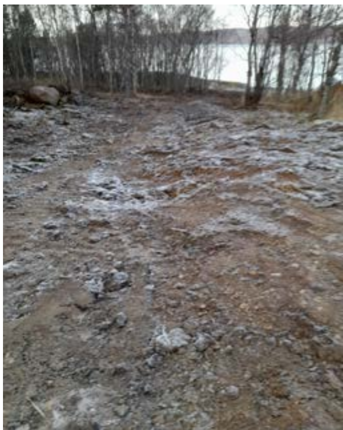
...og så var ledninga pent på plass i bakken
