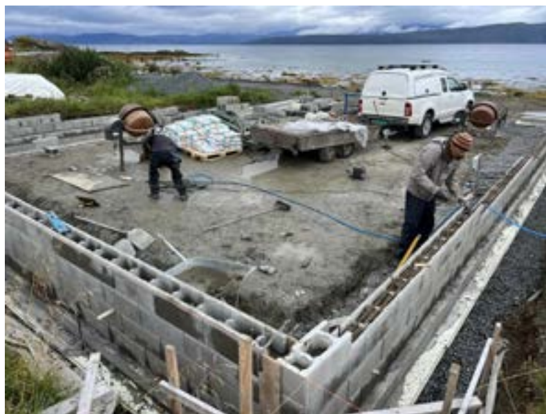
Murerne Per Einar og Paul i full gang med ringmuren
